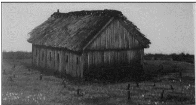
Boerderij in Oostpolder ten westen van Gouda ca 1100, groot 18 bij 11 meter, op een terpje van 40 cm hoog, houten palen met daartussen wanden van gevlochten wilgentenen en leem, stal met matten op de grond voor 8 stuks vee, varkenskot, paard, verbouwt op de natte grond emmertarwe en vlas, haardvuur midden en rook kringelt door gat in het dak, woonruimte lemen vloer, geen zolder, opgegraven in 1996.
